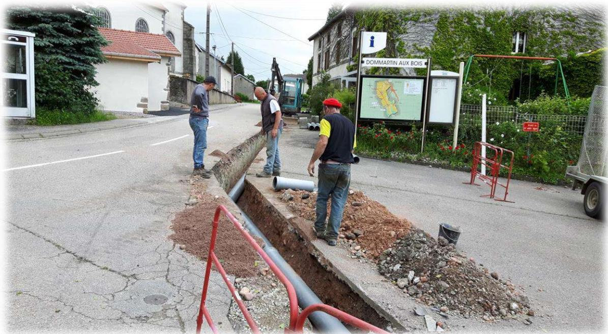
Il a également été nécessaire de modifier le réseau d'alimentation en eau potable, le compteur a été ramené dans le local technique (ancien garage), tous les points d'eau étant maintenant situés dans cette partie du bâtiment.
