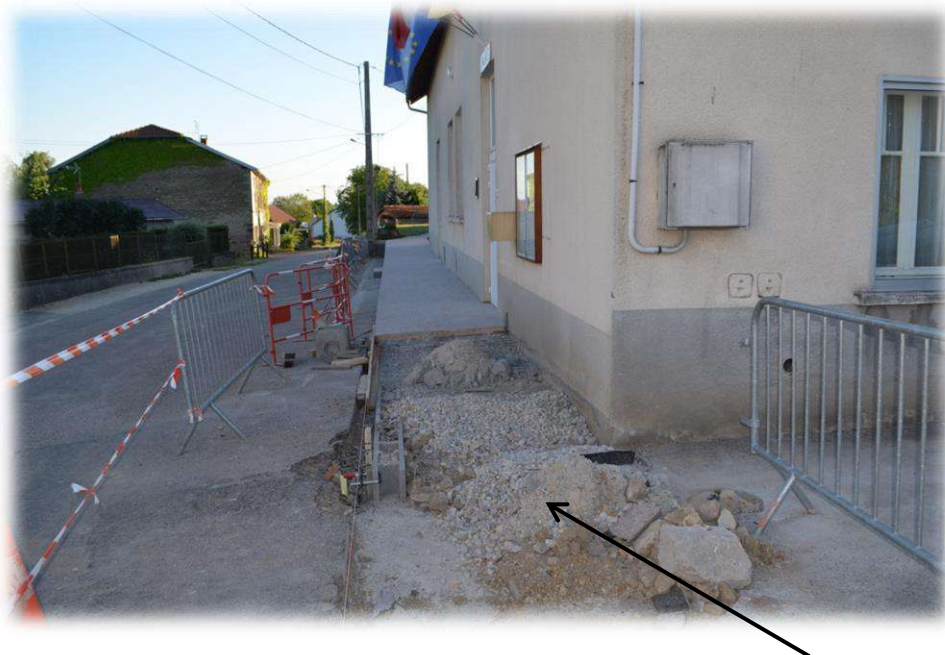
Futur emplacement de stationnement handicapé
