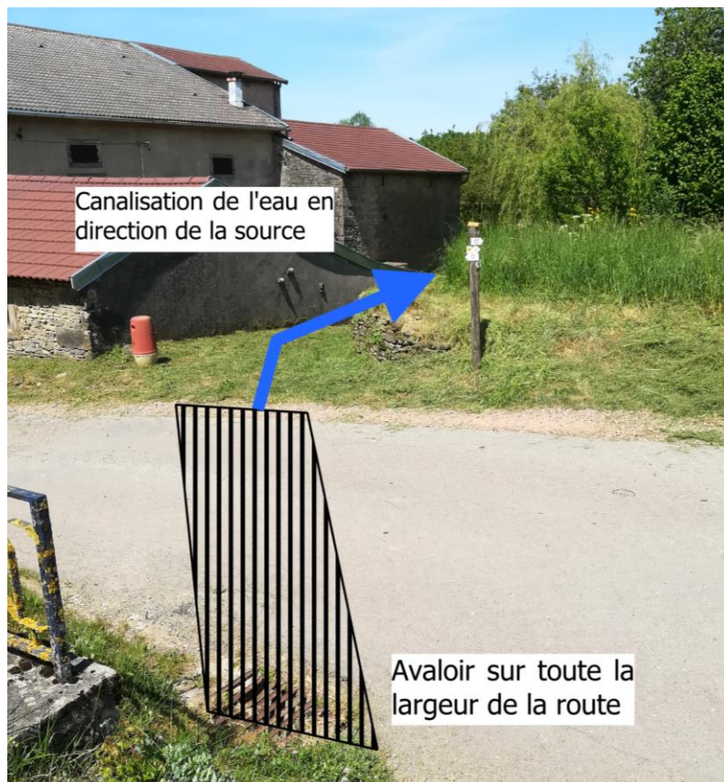
Photo 26 : Agrandissement de l'avaloir sur toute la longueur de la route.
