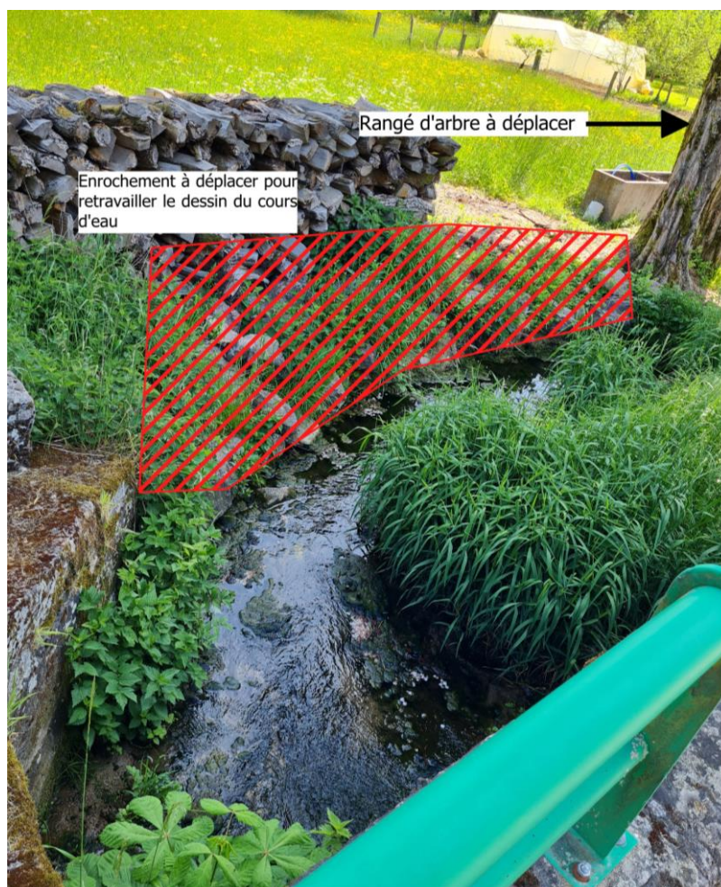
Photo 29 : Dégagement à prévoir à la sortie du pont
