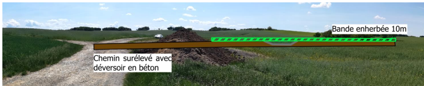
Photo 21 : Aménagement du nouveau chemin.
