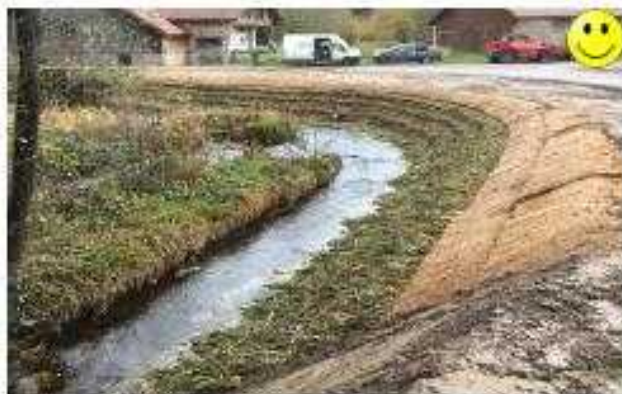
Géotextile et boutures de saules sur le Bouchot
